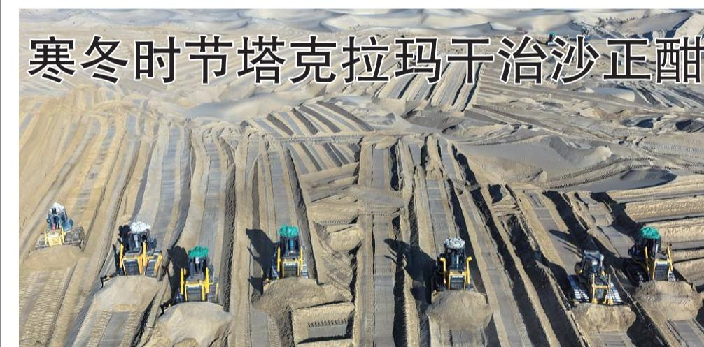
寒冬时节,尽管塔克拉玛干沙漠南缘的新疆和田地区墨玉县气温跌破零摄氏度,却依然涌动着治沙攻坚的热潮。数十台推土机轰鸣作业,推筑阻沙堤、平整沙丘,本地农户忙着收割加工芦苇、铺设草方格,冬季治沙工程高效推进。
